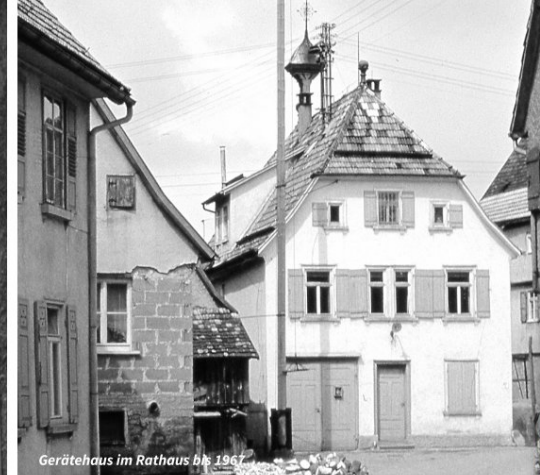
Gerätehaus im Rathaus bis 1967
